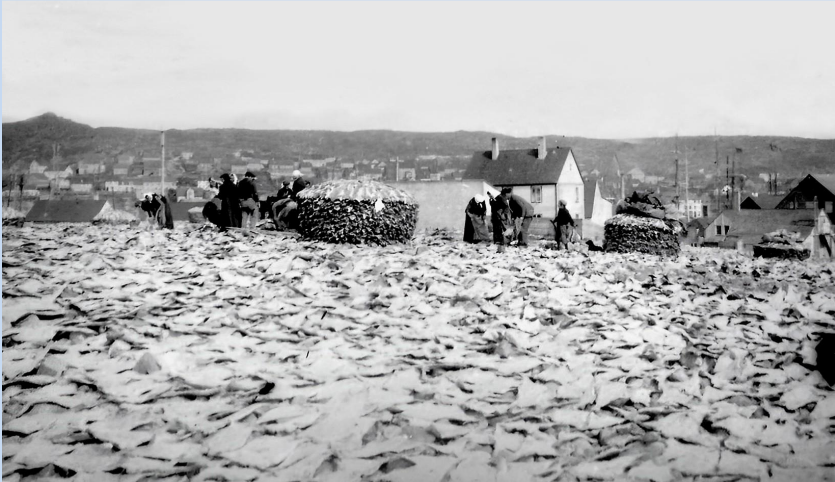
Séchage de la morue sur la grave devant l'habitation Monier, on notera les meules de morues – Photo François Monier
